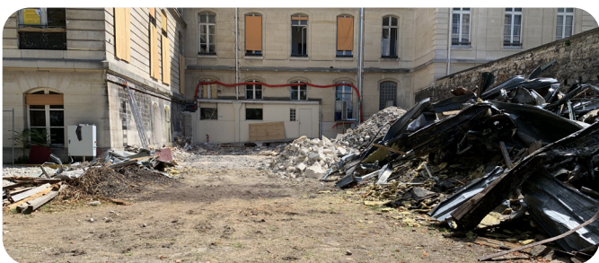
Chantier de l'aile Saint-Jacques en août 2022
