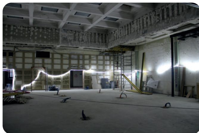
Chantier du Grand Amphithéâtre Henri Poincaré en février 2023
