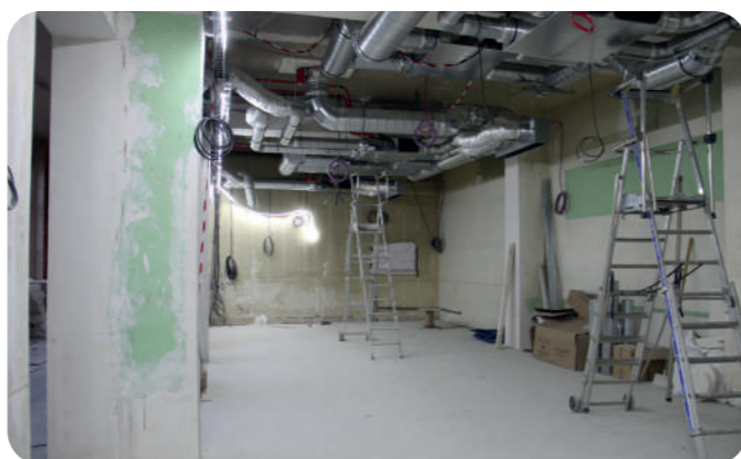
Chantier du Carreau des Mines en février 2023
